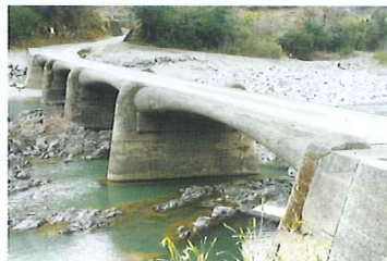
「上岡沈下橋」(かみおか)正式名称は「向山橋」。床板の下部が曲線を描いており、橋脚も丸みを帯びていて、ユニークなデザインで大変美しい沈下橋。
