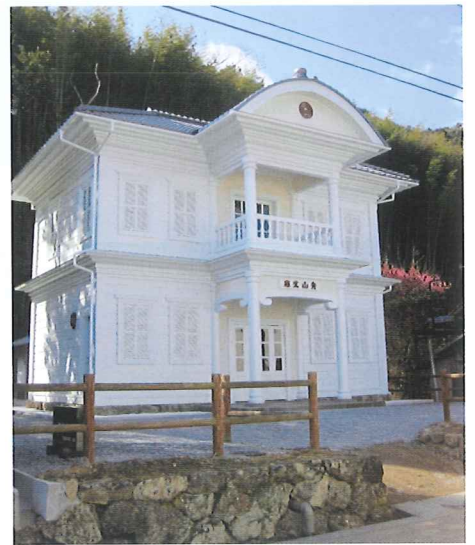
佐川文庫庫舎(さかわぶんこしや)／須崎警察署佐川分署として明治19年建築。その後、青山文庫閲覧室、佐川文庫、民具館等として活用された。県下最古の木造洋館。
