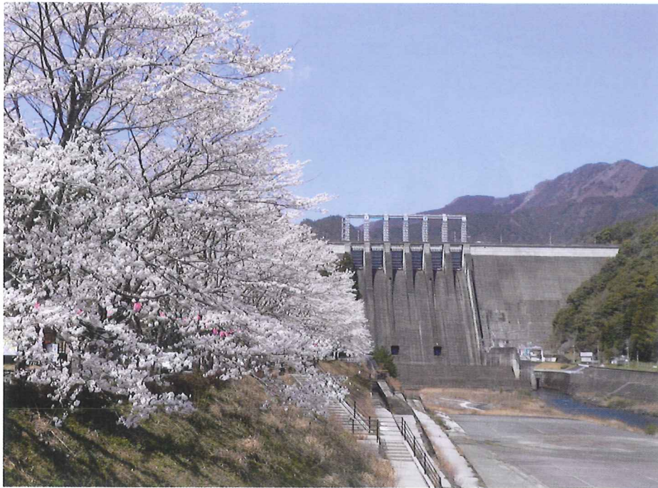
早明浦ダムは日本有数の貯水量を誇る多目的ダムで、春には2,000本もの桜が咲き誇る。
