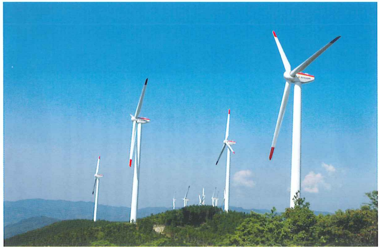
美しい大月町を、未来を担う子どもたちに残すため、平成18年9月に全12基からなる風力発電所「大月ウインドファーム」を建設。
