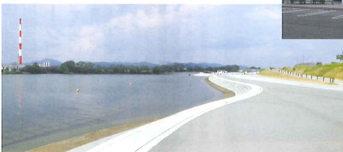
穏やかに流れる今切川の堤防に沿って約1kmにわたって水辺の護岸とスロープが整備されています。また、魚をイメージしたアクアプラザは、隣接する休憩所となっている。
